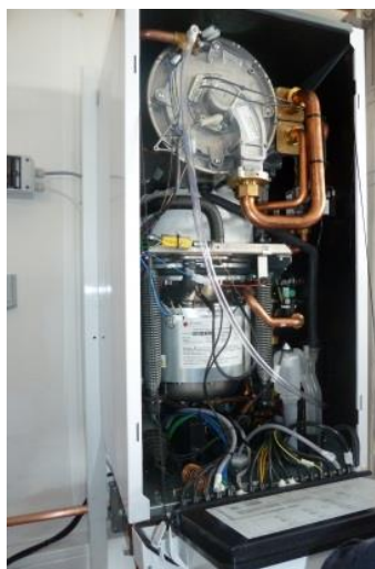
Obr. 26 Kombinace Stirlingova motoru s plynovým kotlem společnosti Viessmann 150
