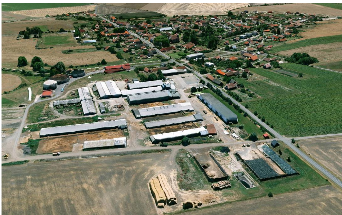
Obr. 3 Letecký pohled na obec Kněžice, v popředí je možné vidět bioplynovou stanici 25
