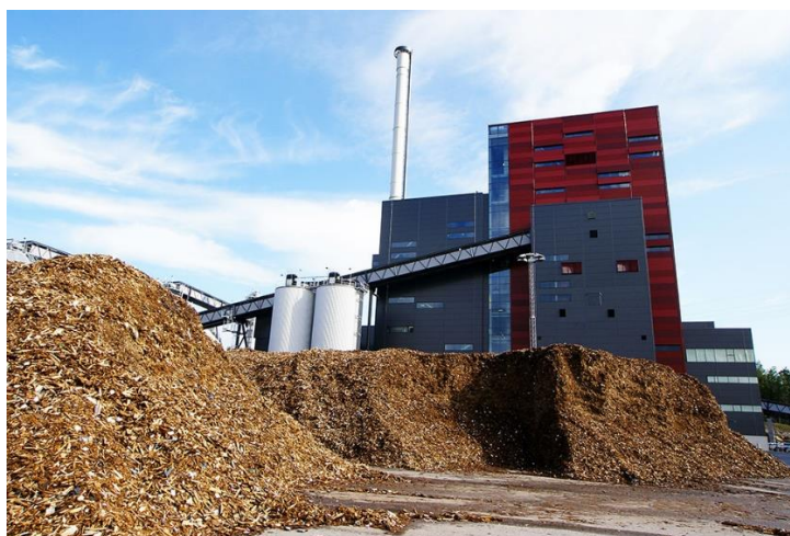
Obr. 20 Elektrárna na biomasu 125
